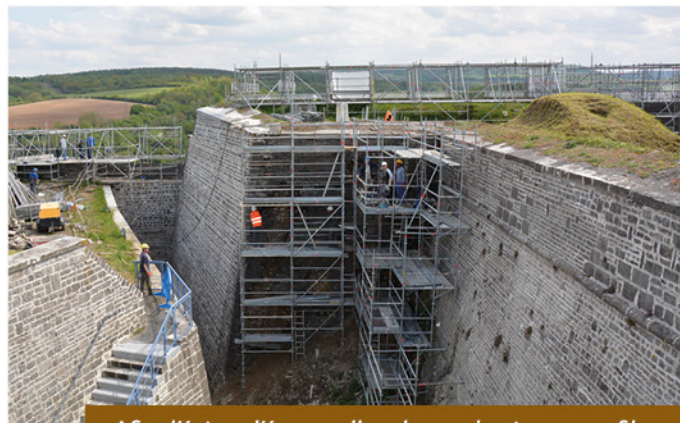
Afin d'éviter d'éventuelles chutes de pierres, un filet de protection sur l'échafaudage avait été installé.
