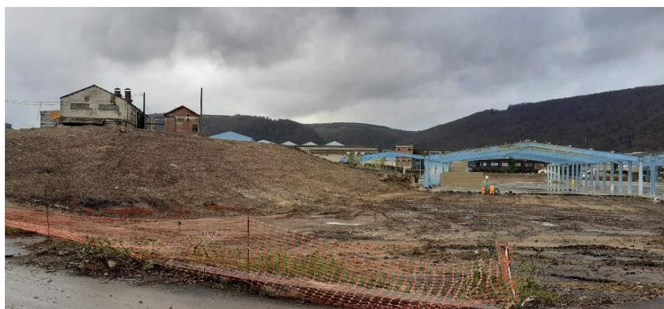
Vues du chantier – Novembre 2023
