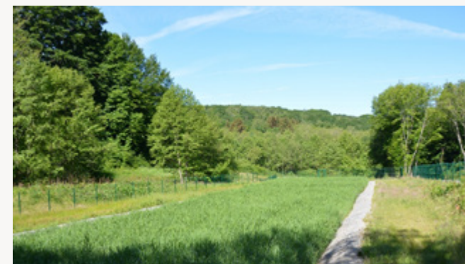
Station d'épuration d'Hargnies
