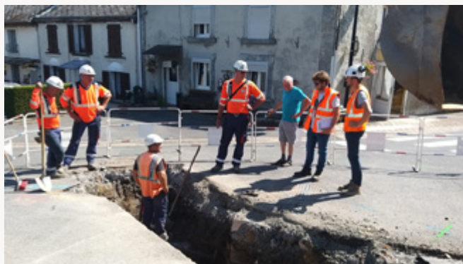
Chantier à Ham-sur-Meuse
